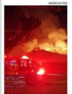
GRAVES DAÑOS DEJÓ ESTE SINISTRO EN LA COMISARÍA.
